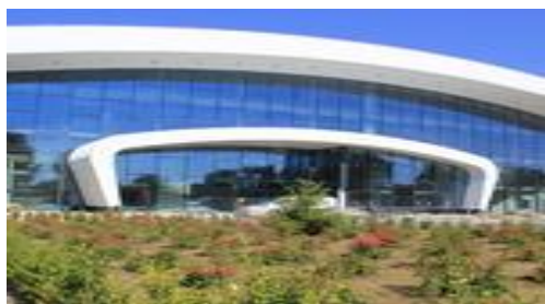
Hala widowiskowo - sportowa, ul. Lubelska 59
